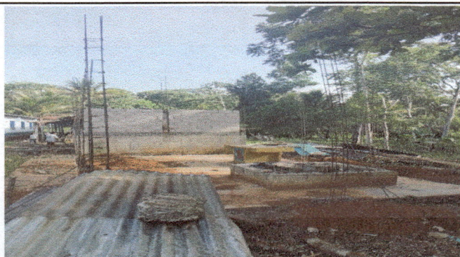
Foto 3: Desmontaje de estructura de madera de cocina y aula.
