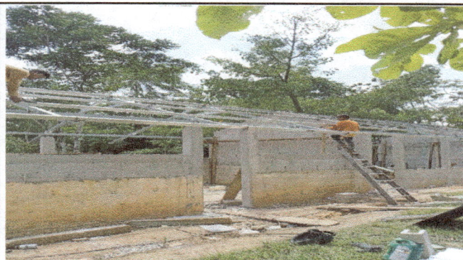
Foto 4: Instalacion de estructura portante.
