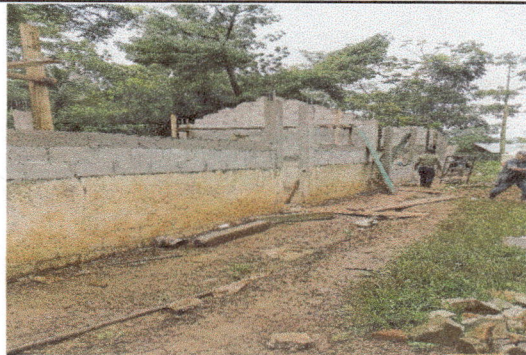
Foto 2: Remozamiento de aula y cocina.
