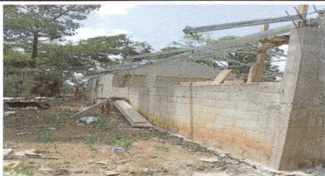
Foto 5: Instalacion de estructura portante.
